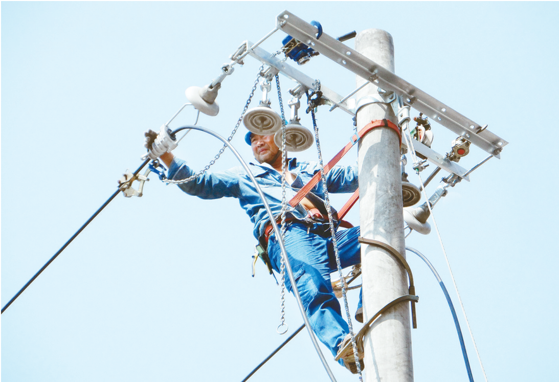
6月26日，漯河供电公司电力工人在纬一路检修供电设备。连日来，漯河供电公司对辖区输配电线路加强巡视和检修，并升级供电设备，确保电网设备稳定运行。
