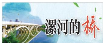
太行山路澧河大桥,2010年6月竣工,下拱桥结构,桥梁全长297.12米,桥面总宽30米。桥体栏杆由292块汉白玉石板,324根汉白玉石柱组成,石板上刻有双狮戏球浮雕,每根石柱上端雕刻着玲珑活泼的石狮子。 本报记者 焦海洋 摄
