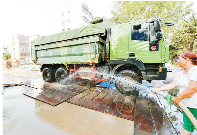
7月24日,在市区建设路一工地出入口,保洁人员正在冲洗渣土运输车的轮胎。据了解,为有效抑制扬尘,市区各工地都配备了保洁人员,随时对进出工地车辆的轮胎及工地周边路段进行冲洗。 本报记者 焦海洋 摄
