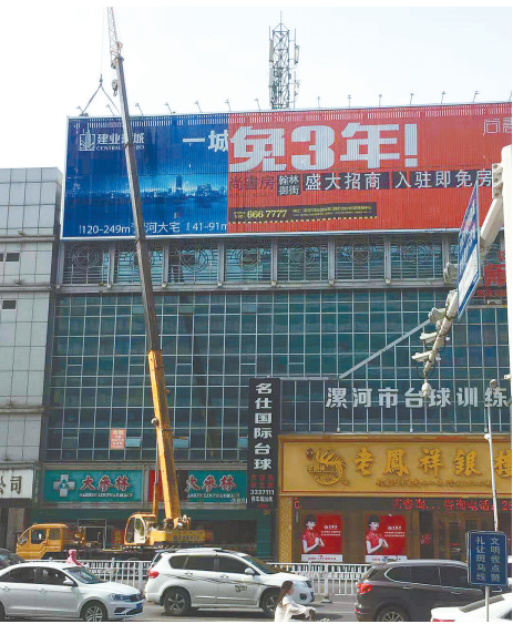
7月23日,市城管综合执法支队源江大队、源汇区城管大队和马路街办事处联合对交通路与人民路交叉口东南角楼顶的4块违规户外广告牌进行了拆除。
