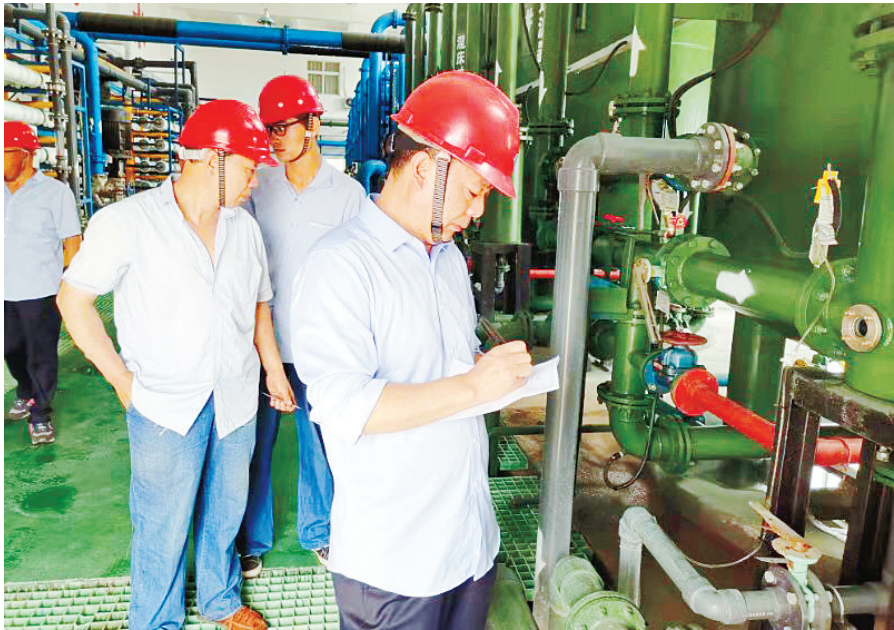
7月23日，漯河恒瑞热电厂组织开展设备安全大检查，查漏补缺，确保设备安全稳定运行。本报记者 张玲玲 摄
