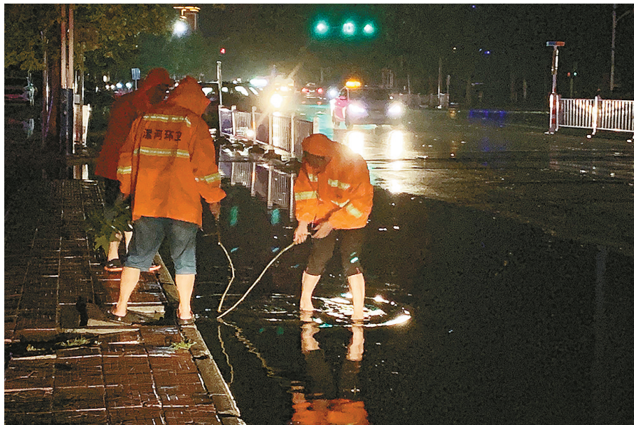
市政抢险队在湘江路排查窞井。
