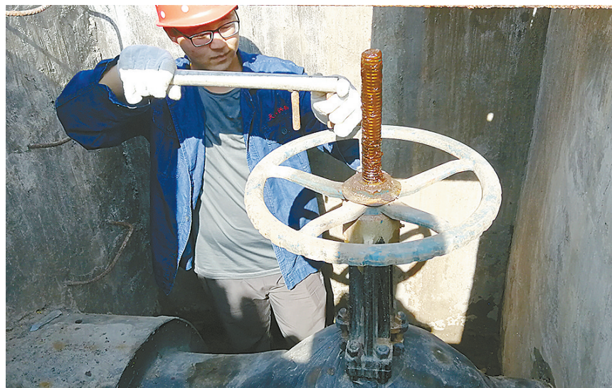
为保证我市企业生产正常用热，热力工作人员冒着酷暑辛勤工作，为用户提供优质、便捷的供热服务。图为8月7日，漯河天阳供热公司工程热网班员工在阀门井内作业。
