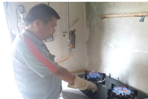
乡村“煤改气”用户通气点火现场
