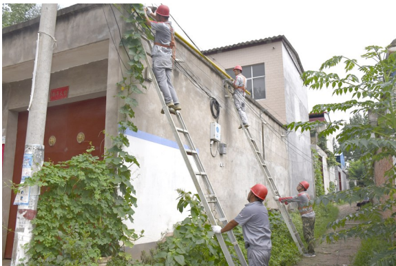
乡村“煤改气”庭院管道施工
