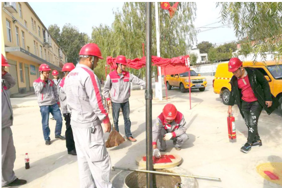
召陵区鲍姬线中压管道置换通气
