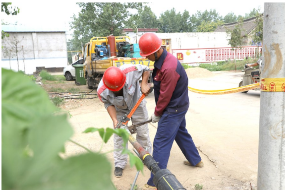
龙城镇庙张村乡村“煤改气”中压管道吹扫作业
