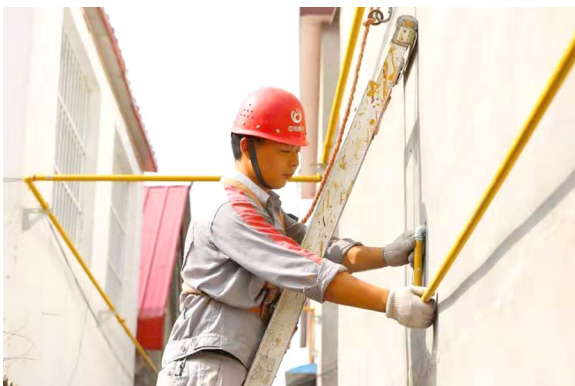
李集镇西营村庭院管道施工
