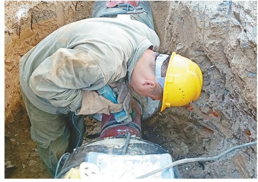
9月15日,热力工人在崂山路施工管沟内焊接热力管道。崂山路(辽河路—黄河路段)热力管网是我市规划的一条热力主管网,全长约700米,截至目前已经完成管沟开挖约500米,管道安装450米,预计9月底该段工程能全部完工。
