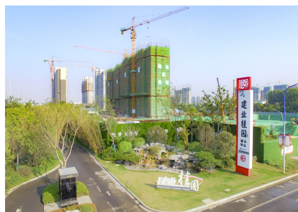
建设中的建业桂园项目
