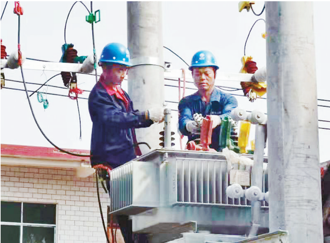
国庆期间，漯河供电公司加紧推进郾城区裴城镇田古东行政村“煤改电”工程，为该村新增8台变压器，更换高低压线路，将有效解决该村供电半径不足、低电压等问题。杨书军 摄
