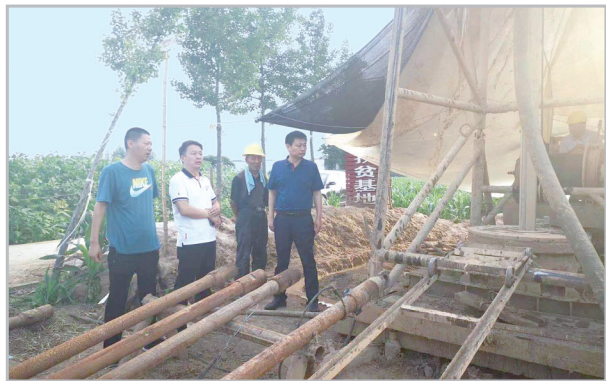
农村饮水工程水源井建设。
