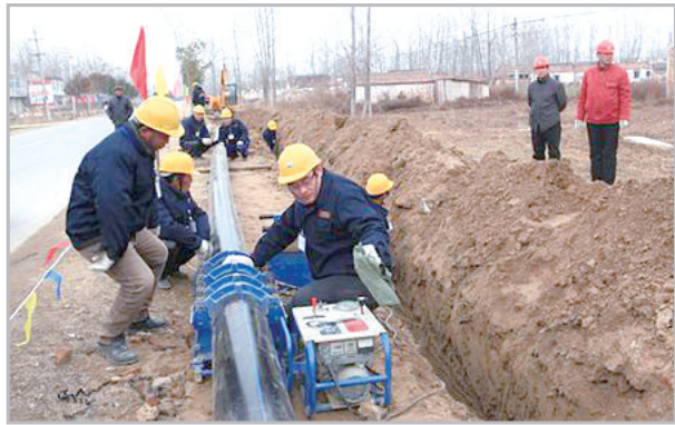
农村饮水全覆盖工程。
