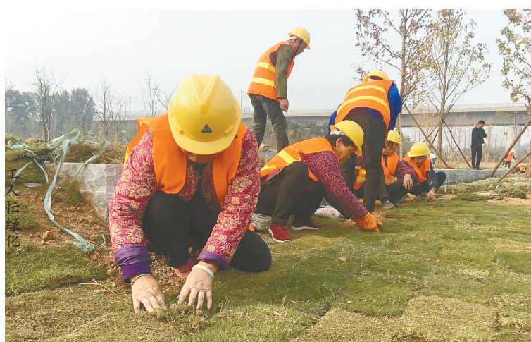
工人在铺设草皮。
