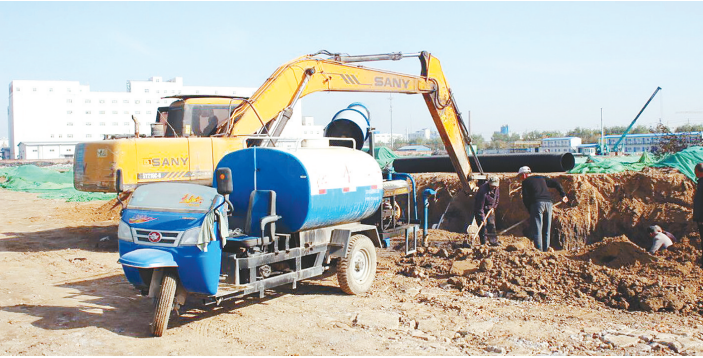
近日，经济技术开发区规划四路开工建设。该路北接漓江路，南接湘江路，全长602米。图为该区公用事业管理处正在清理施工现场。
