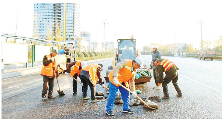
近日，为助力我市文明城市创建，经济技术开发区公用事业管理处组织人员对辖区内破旧路面进行全面整修。 赵楠 摄
