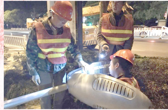
夜间照明维修
