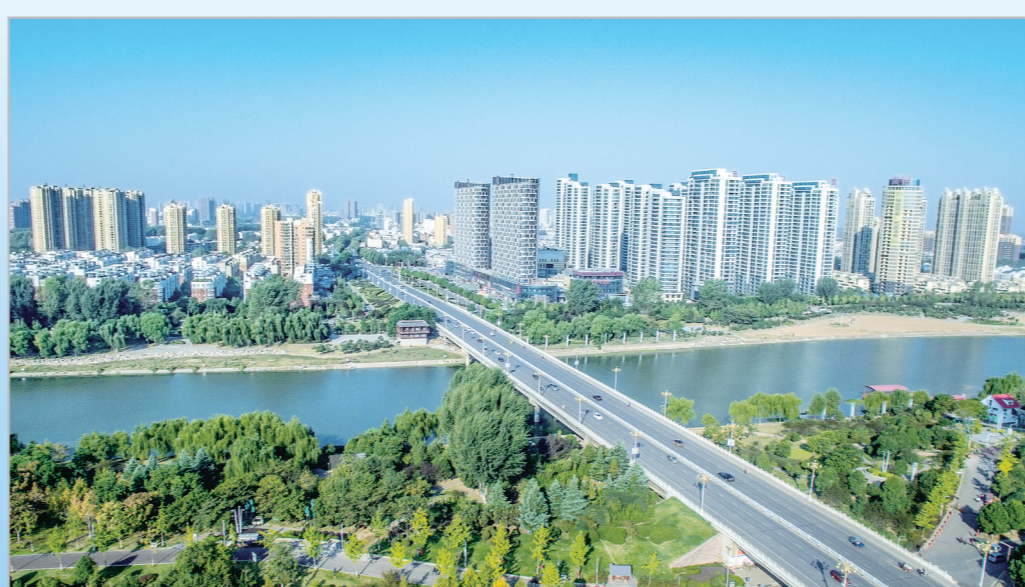
黄河路沙河大桥项目,总投资7000万元。
