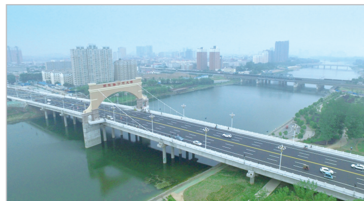
解放路沙河大桥项目,总投资2.4亿元。
