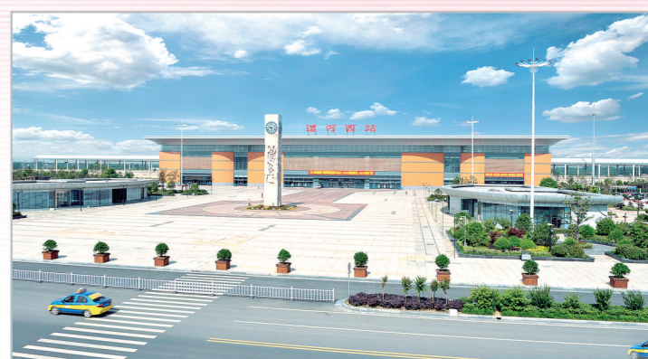
高铁火车站项目,总投资7500万元。
