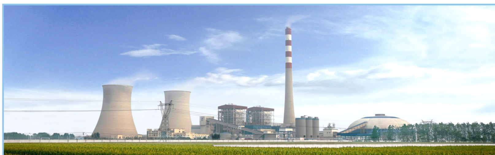
发投集团参股子公司华电漯河发电公司全景
