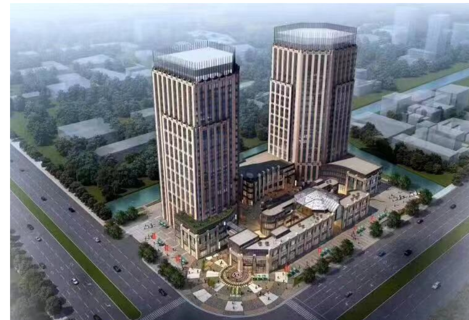
发投集团所属企业华鼎公司承建的世界港综合体项目
