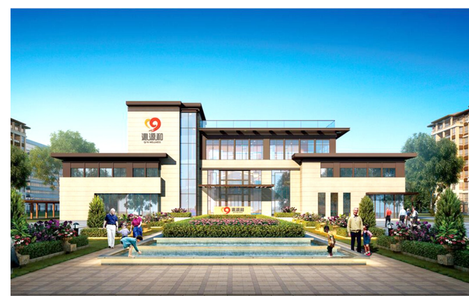
发投集团参股承建的昌建医养园沁源和项目
