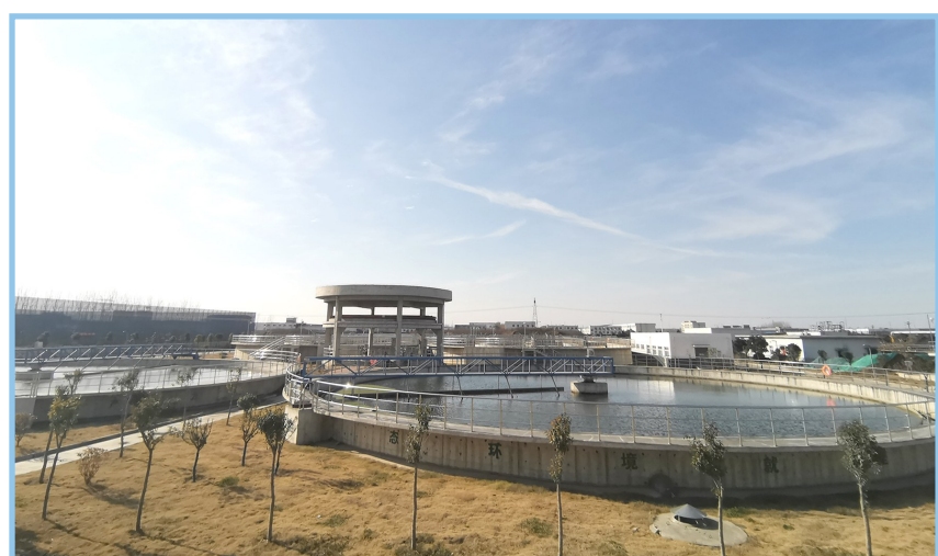
发投集团所属企业承建的开发区污水处理厂
