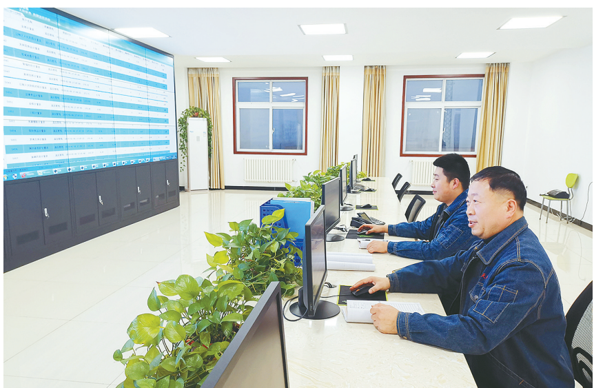
1月7日,漯河天阳供热公司工作人员在调度室进行热力调度。为应对雨雪降温天气,保障供暖工作正常有序开展,漯河天阳供热公司加强热力调度,优先保障市民采暖。 本报记者 王艳彬 摄
