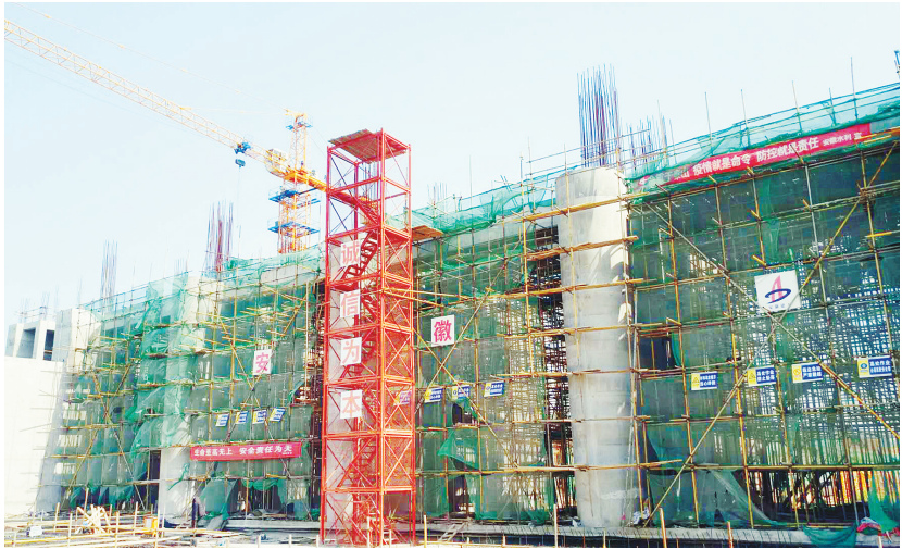
建设中的沙澧连通工程新河道节制闸。
