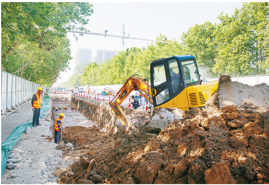
“五一”期间的大行山路雨污分流工程施工现场。
