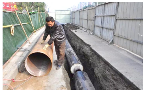
施工人员在铺设供热管道。
