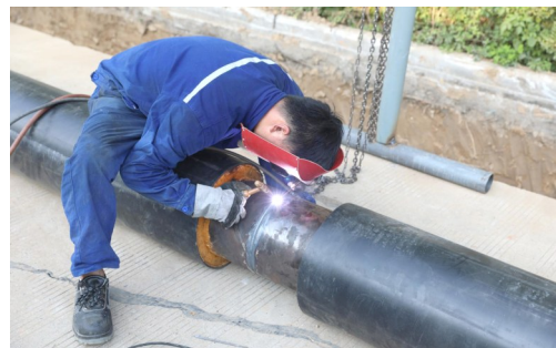
施工人员按照标准对供热管道进行焊接。
