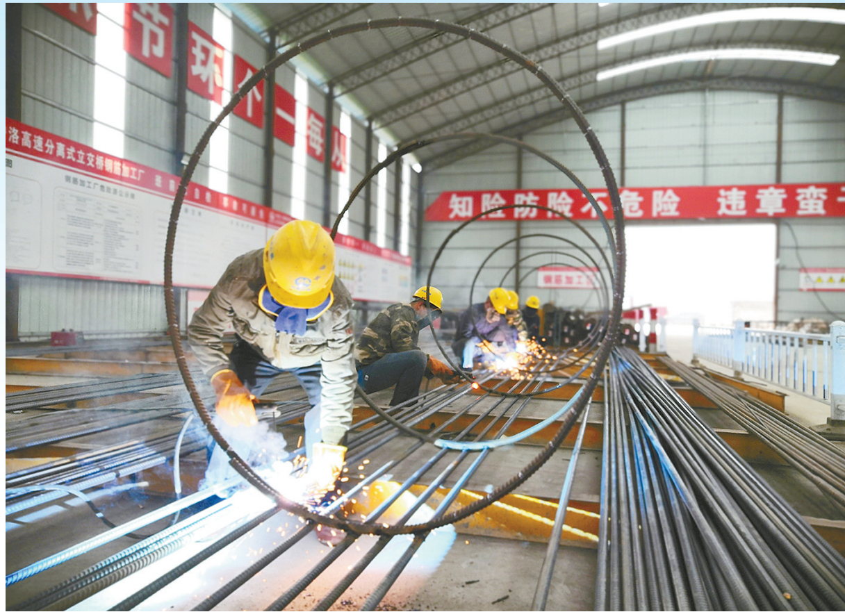
西环线上跨宁洛高速公路分离式立交桥工程建设工地。 本报记者 王辉 摄
