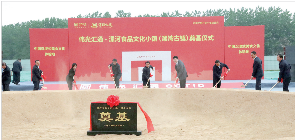
招商引资成效丰硕,发展后劲持续增强。图为伟光汇通·漯河食品文化小镇(漯河古镇)项目奠基仪式。
