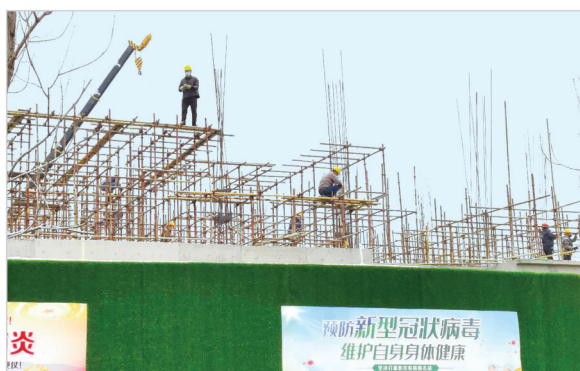
建设中的双汇人才公寓项目。
