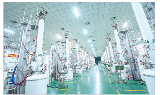
河南协鑫光伏科技有限公司生产车间。
