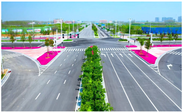
高铁西部路网框架不断完善
