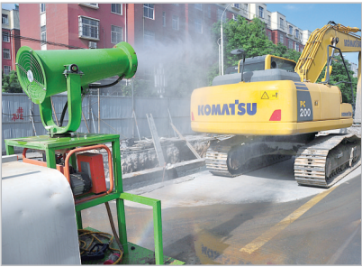
雾炮机在施工现场作业。
