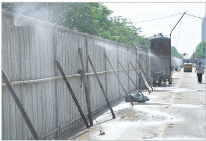
施工围挡喷淋设施抑制扬尘。
