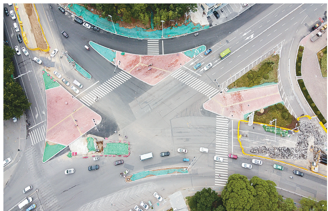
改造后的泰山路与湘江路交叉口。
