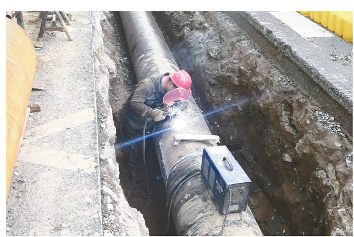
7月29日,在市区祁山路,工人正在焊接热力管道。据了解,祁山路(淞江路至辽河路)热力管道全长约500米,7月16日开始施工,目前已完成管沟开挖,计划本周末完成管道安装。 本报记者 王艳彬摄
