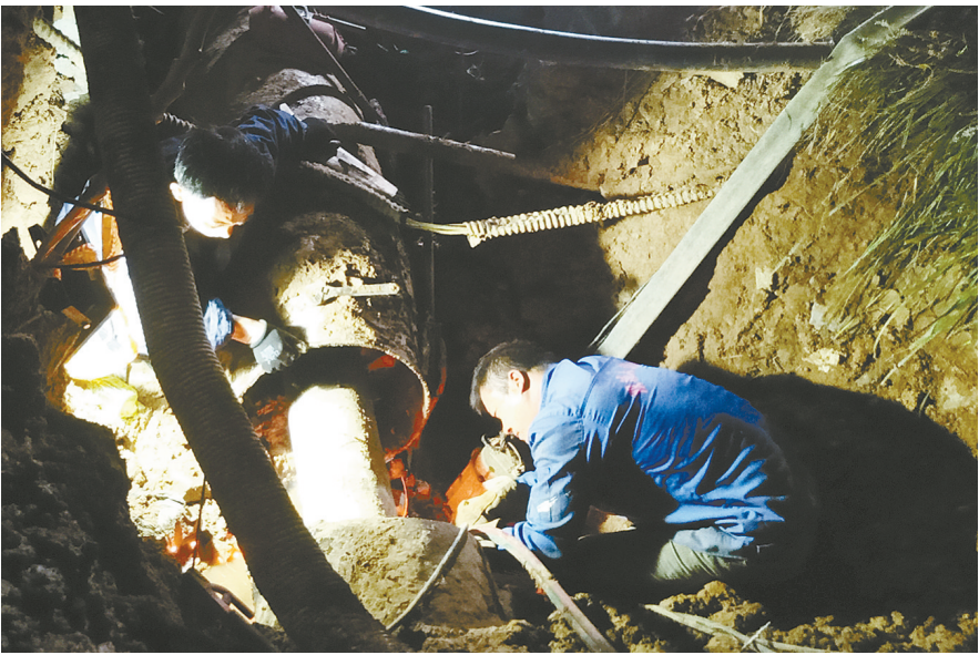
近日，漯河天阳供热公司启动2020年城市供热“冬病夏治”专项行动，对供热管网进行换管、维修和改造。图为热力工人拆除旧管、焊接新管，并对部分腐蚀严重的外管进行焊接加固。 本报记者 王艳彬 摄
