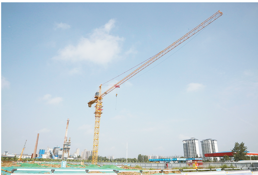
8月16日,河南中烟工业有限责任公司漯河卷烟厂易地技术改造项目正在加紧施工中。该项目位于经济技术开发区,主要包括生产联合工房、生产管理用房、生活配套用房、动力中心、污废水处理站等及其配套设施。预计本月底完成联合工房网架区基础承台、地梁施工作业。
