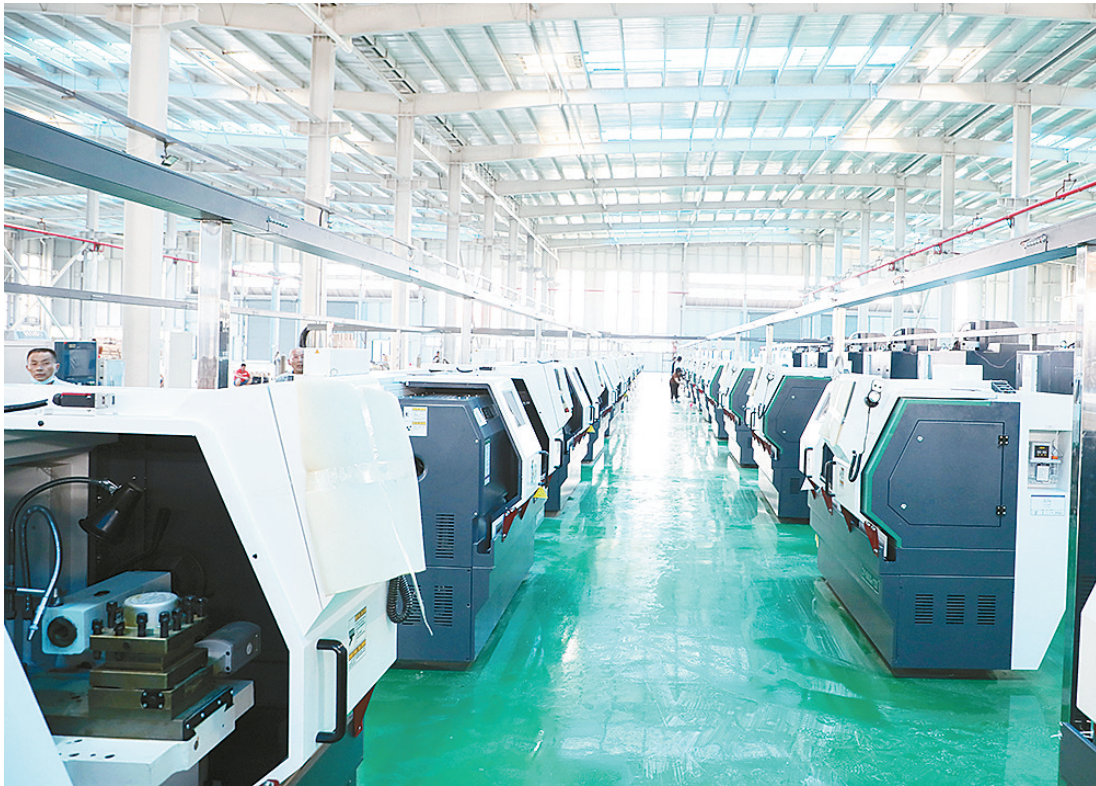
8月19日,位于经济技术开发区的智能食品装备产业园项目一期正在加紧施工建设中。据悉,该项目占地面积127亩,投资3亿元,4栋专用标准厂房已完工,1栋9层的综合展示交易中心正在建设第6层。产业园内3家生产型企业目前进入投产准备阶段,计划本月底全部正式投产。
