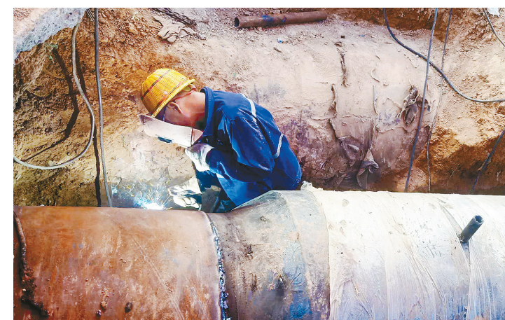
近日,漯河天阳供热有限责任公司工人在燕山路维护管线。为保证今冬安全供暖,提高供热质量,漯河天阳供热有限责任公司对热力设备进行了维修和保养。 本报记者 焦海洋 摄
