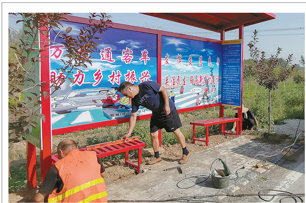
“俺村里也有候车亭了!”9月8日，郾城区孟庙镇西管村村民笑逐颜开地告诉记者。在李溧路上，郾城区交通运输局安排工作人员正在安装候车座椅。为了改变农村交通环境，郾城区以全省交通配套设施项目建设为契机，将候车亭建设纳入民生工程范畴，加大资金投入建设农村公路候车亭。
