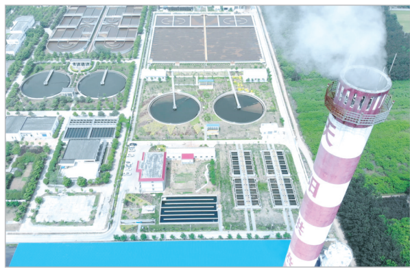
沙北污水处理厂向企业供应中水。
