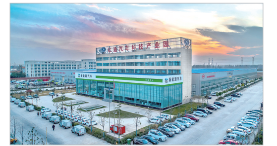
亿通汽车科技产业园
