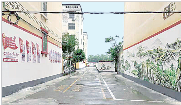
改造后的老旧小区
