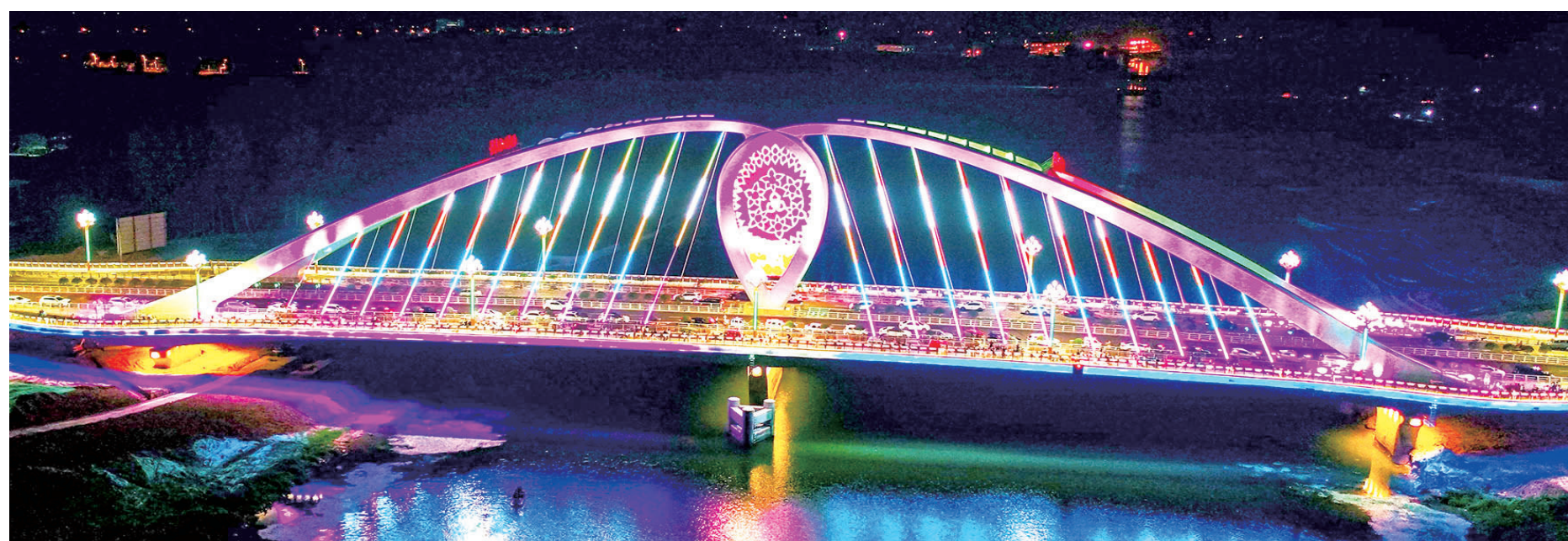
建成通车的牡丹江路大桥
