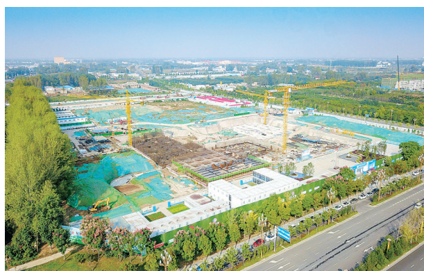
在建的双汇总部
