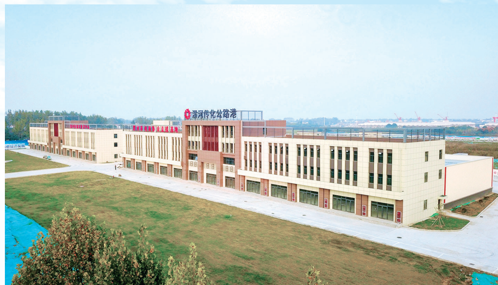
漯河传化公路港
