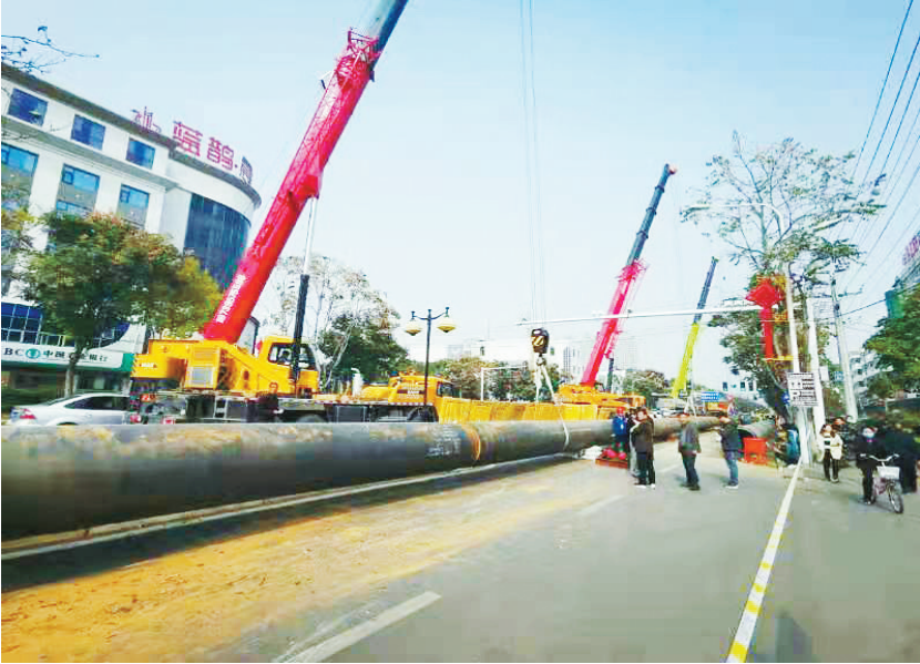
市住建局相关负责人现场督导华电漯河源汇区热网项目穿越澧河施工工作。
