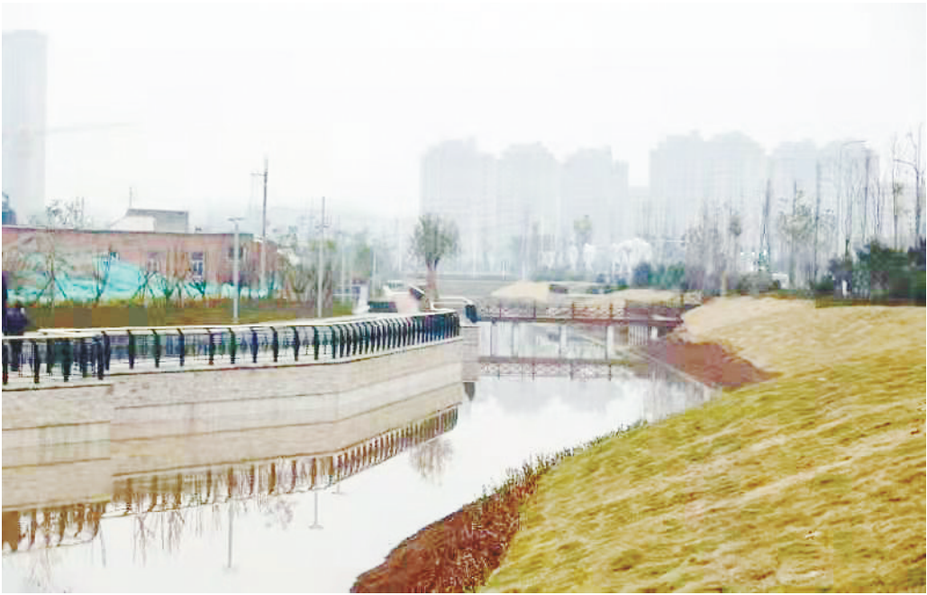
幸福渠交通北路工程已正式通车。
