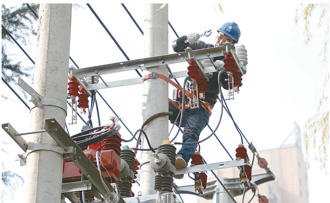
12月12日,漯河供电公司工作人员在10千伏淞江路主线检修、安装供电设备。据了解,连日来,漯河供电公司工作人员对供电线路、设备等进行集中检修,严防电网输变电设备过载或超稳定运行,确保冬季用电高峰用电安全。 本报记者 范子恒 摄
