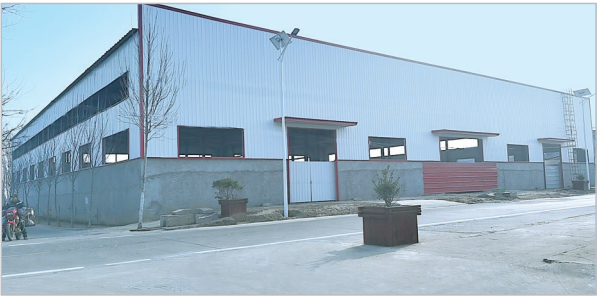
关徐村冷链仓储建设项目。
