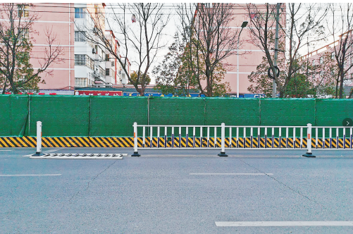
五一路南段森林庄园小区对面,道路中间隔离栏倒地。
