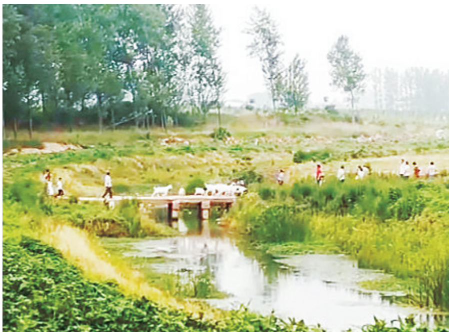
横跨在三里河上的曹家古桥。
