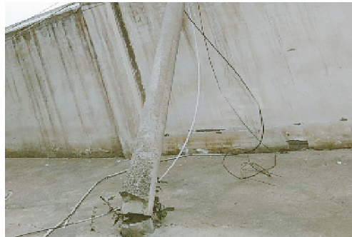
岷江路与白云山北路交叉口福星鑫园小区，线杆断裂。
