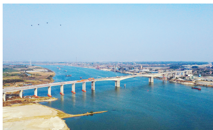
1月26日拍摄的成功合龙的北江特大桥（无人机照片）。当日，由中铁大桥局承建的广佛肇（广州—佛山—肇庆）高速公路北江特大桥顺利合龙，北江特大桥位于佛山市三水区与肇庆市大旺区交界处，跨越北江沟通两地。北江特大桥顺利合龙标志着广佛肇高速实现全线贯通，粤港澳大湾区再添一条交通大动脉。 新华社记者 刘大伟 摄
