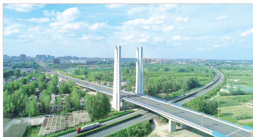
经开区中山路立交桥。
