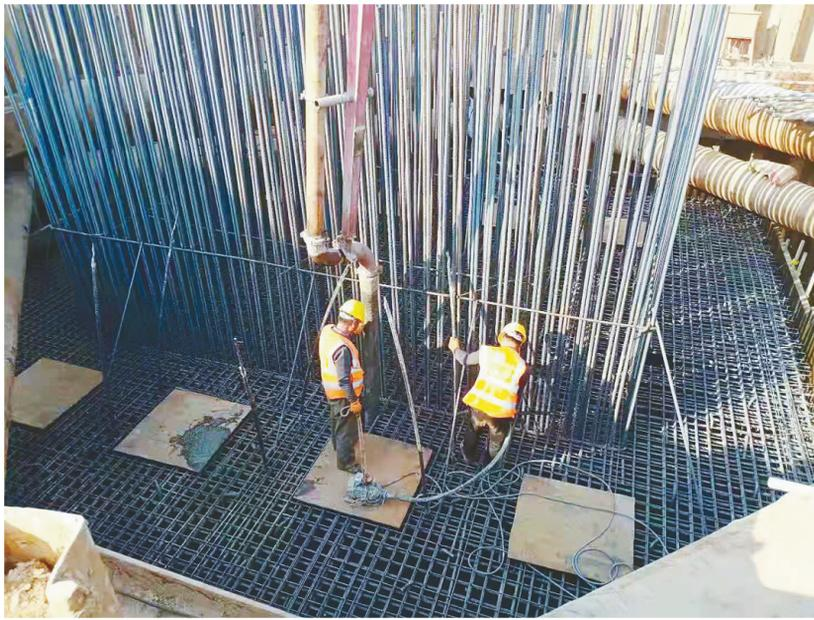
2月8日,在舞阳县莲花镇玉皇庙村附近的许信高速公路项目工地,工人们正在进行沙河大桥混凝土浇筑。“沙河大桥主桥墩计划今年5月底浇筑完成。”施工方负责人告诉记者,春节期间工地将不间断施工。到今年年底,许信高速公路漯河段将完成全线路基填筑,桥梁架梁完成80%。本报记者 张晓甫 摄
