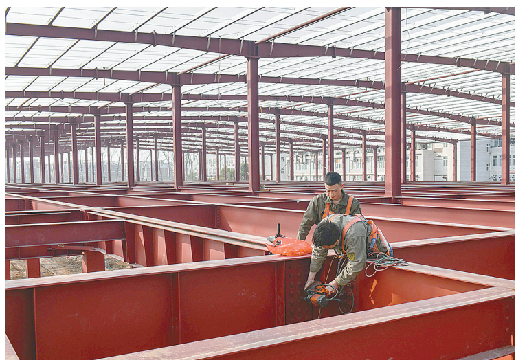
2月22日, 在漯河泓一食品有限公司生产项目工地, 工人们正在施工。 本报记者 焦海洋 摄
