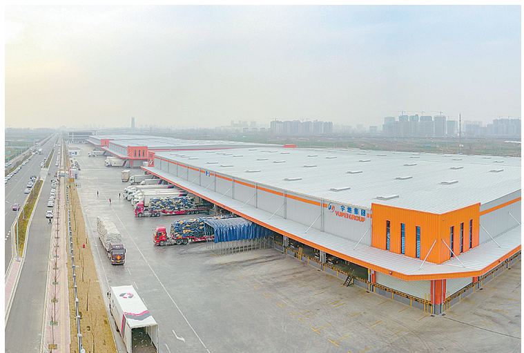
2月22日, 在宇培开发区物流园百世快递漯河转运中心, 运输车辆正在发运快件。 本报记者 焦海洋 摄
